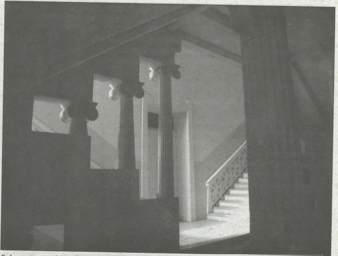
Colunas e escadaria de acesso ao primeiro andar do prédio da FAMEB no Terreiro de Jesus Foto do Prof. Fernando Carvalho
